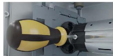
Connexion du tablier à l'axe, mise en place des butées rondes et fermeture du coffre.
