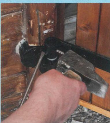
**11** Une fois le scellement sec, démontez les volets et ôtez les bagues. Alignez le trou de l'œil de penture et celui du gond. Insérez le manchon de liaison fourni à petits coups de marteau.
