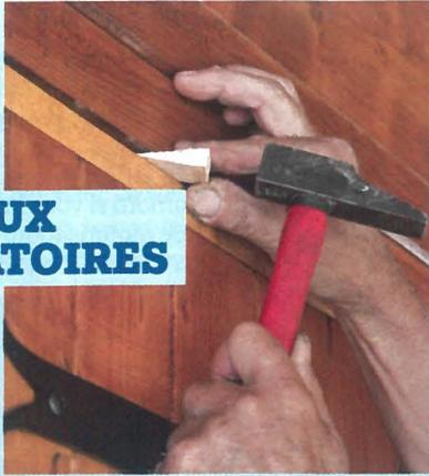
**1** Avec des cales en bois, bloquez le volet en le maintenant dans sa position fermée. Ne serrez pas trop les cales au risque de fausser le réglage d'origine.
