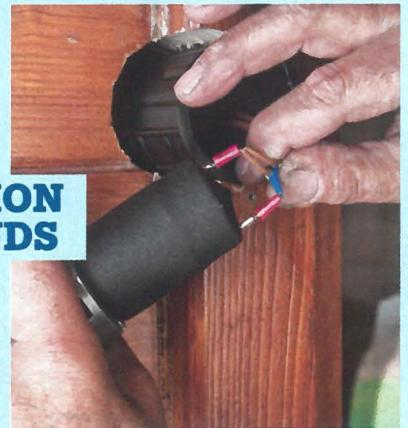
**7** Placez les joints d'étanchéité sur le moteur et introduisez les cosses dans les emplacements dédiés. Attention aux polarités : le point blanc à l'arrière du moteur indique le plus.
