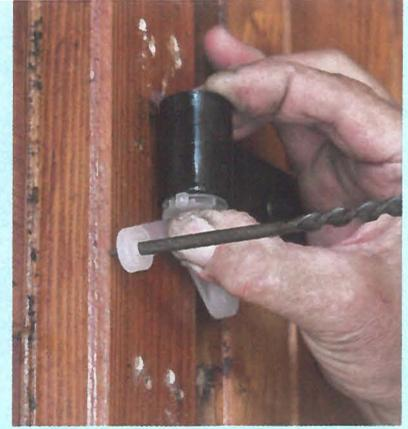
**3** Placez le gabarit de perçage fourni dans les yeux des pentures du volet. Faites un poinçonnage avec une tige métallique pour marquer l'emplacement du futur perçage.
