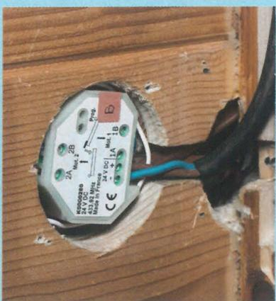
**13** Placez le boîtier de commande dans une boîte à encastrer  $\varnothing$  60 mm et raccordez les moteurs des gonds selon le schéma de montage fourni par le fabricant.
