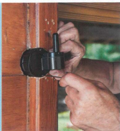
**8** Glissez le moteur équipé de ses fils dans le cache d'encastrement en le tournant sur lui-même pour torsader les fils. Vérifiez que le joint est en place et revissez les deux vis.
