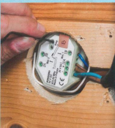
**14** Après mise sous tension, enfoncez le bouton sur le boîtier pour activer le cycle d'apprentissage des volets. Les vantaux s'ouvrent et se referment: le système est opérationnel.
