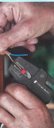
**6** Faites passer du câble électrique 2 x 0,75 mm<sup>2</sup> par le trou au fond de la réservation et dénudez les fils sur 15 mm. Enfoncez le cache. Sertissez une cosse sur chaque partie dénudée à l'aide d'une pince multiprise.
