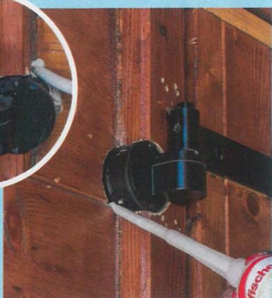
**10** Insérez une bague de montage sur les gonds. Remplacez le volet et injectez du scellement chimique autour du moteur après avoir dépoussiéré le logement à l'aspirateur.
